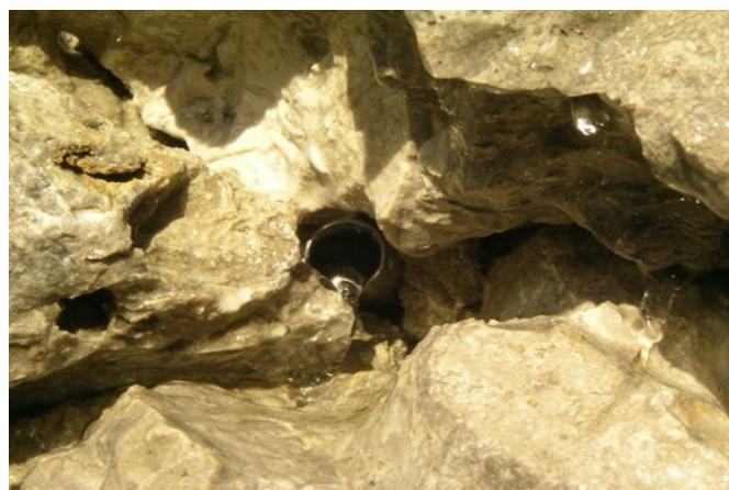
Ugello dal quale fuoriesce uno dei tanti piccoli rigagnoli per bagnare il muro
